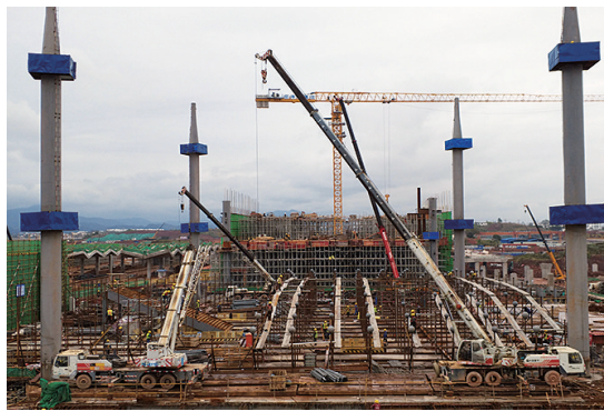
▲诸多机械配合施工
