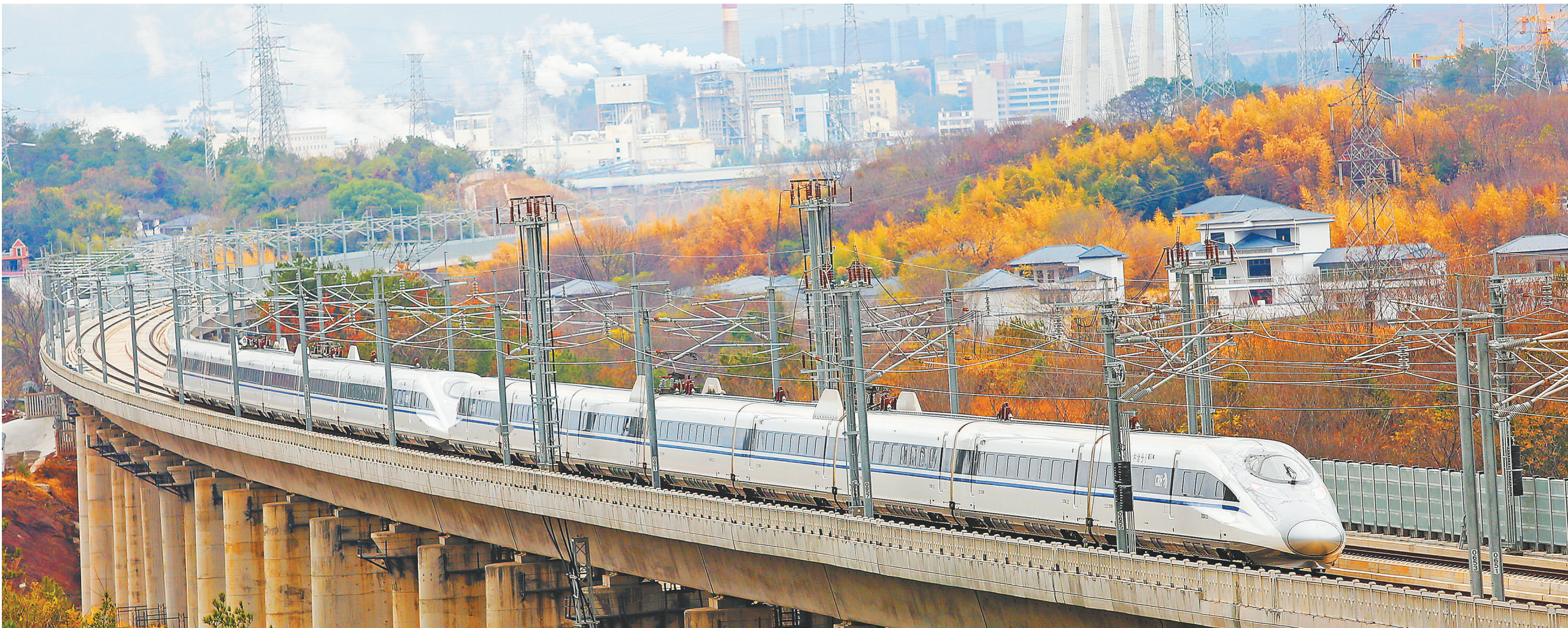
12月26日,昌赣高铁正式开通运营,和谐号高铁列车行驶在位于章贡区水东镇的金龙特大桥上,列车与秋色相映衬。
