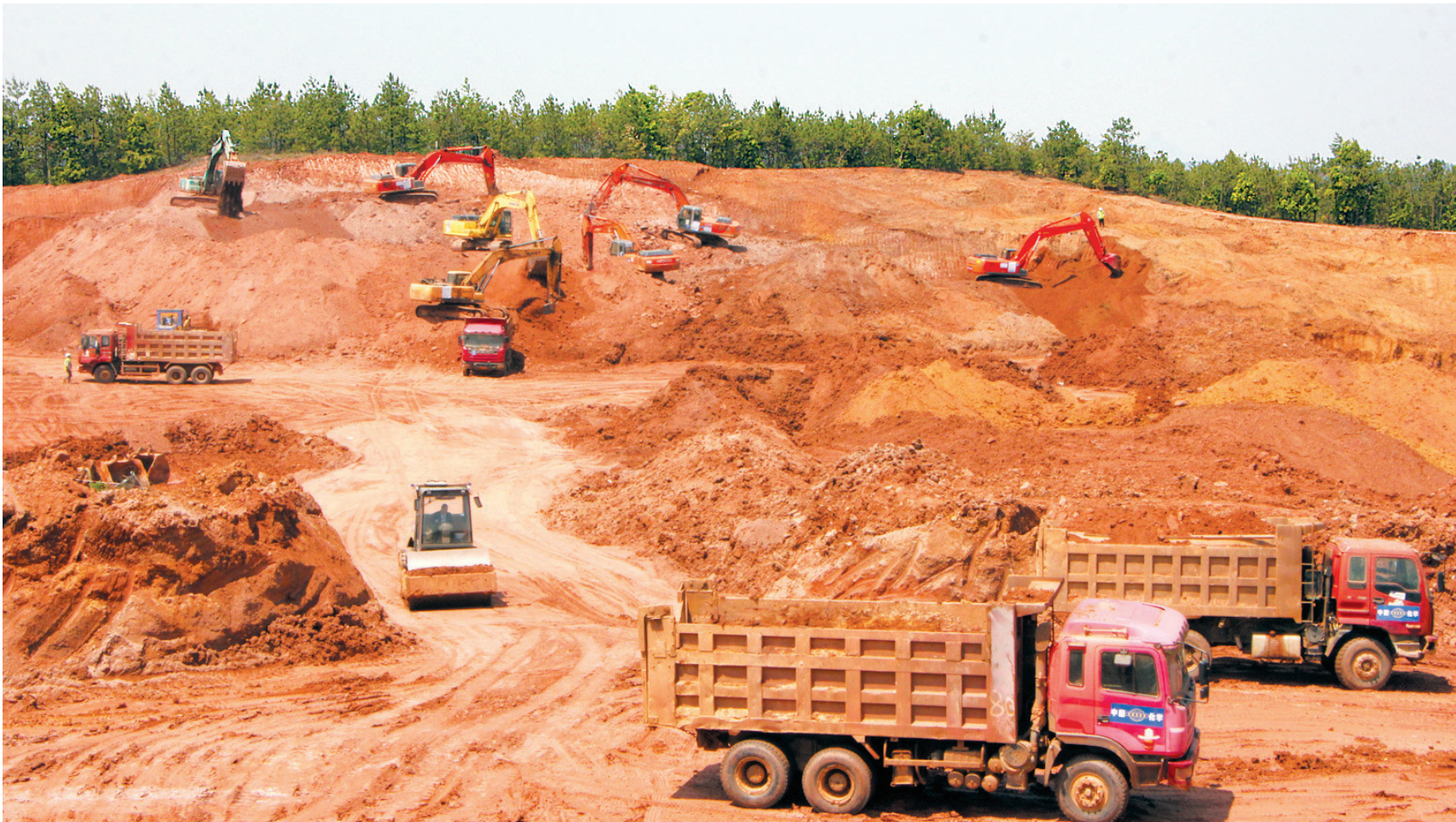
4月12日，多台挖掘机、压路机等在粤港澳高新产业园项目现场作业。该项目一期占地1300亩，将投资100亿元，力争打造粤港澳大湾区优质产业转移承接地。南康经开区全力推动该项目开工复工，实行“一个项目、一个挂联领导、一个工作专班、一个防疫方案、一个工期计划”的工作机制，力争疫情防控与项目建设两不误。
