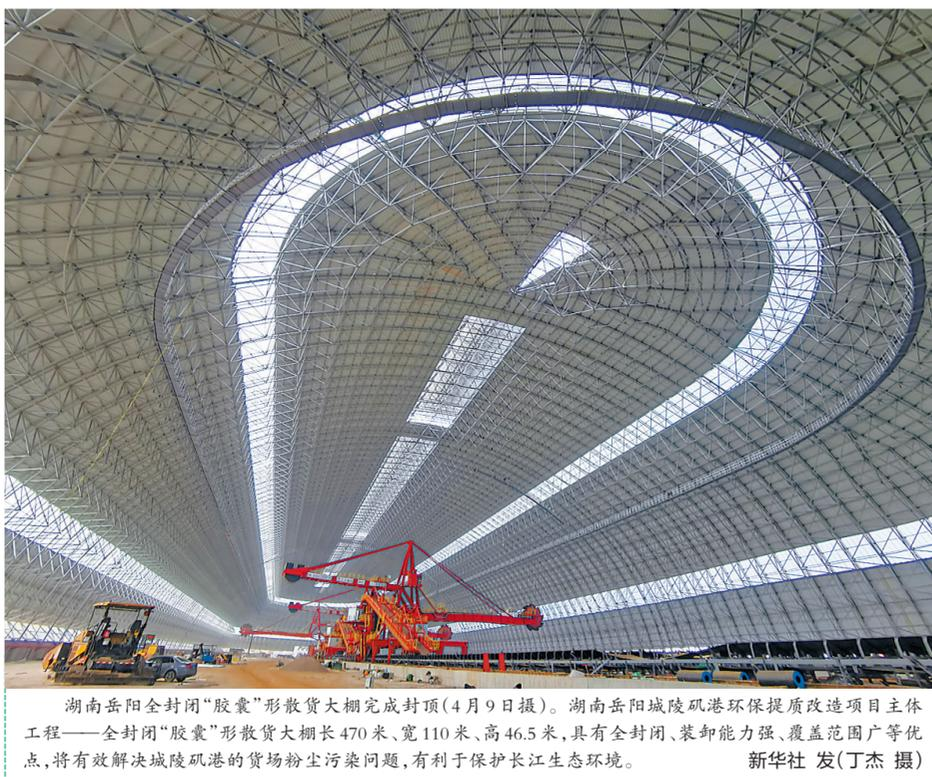
湖南岳阳全封闭“胶囊”形散货大棚完成封顶(4月9日摄)。湖南岳阳城陵矶港环保提质改造项目主体工程——全封闭“胶囊”形散货大棚长470米、宽110米、高46.5米,具有全封闭、装卸能力强、覆盖范围广等优点,将有效解决城陵矶港的货场粉尘污染问题,有利于保护长江生态环境。 新华社发(丁杰 摄)
