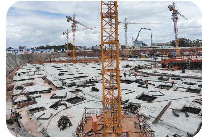
↑赣州软件产业园建设项目在地地下室垫层施工。
