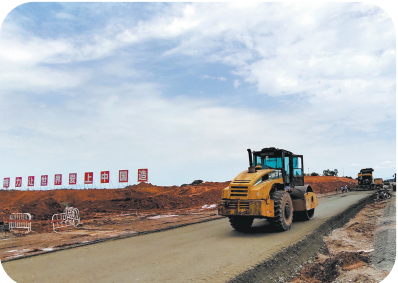
↑赣粤产业合作区（南康片区）项目在铺设格力大道。
