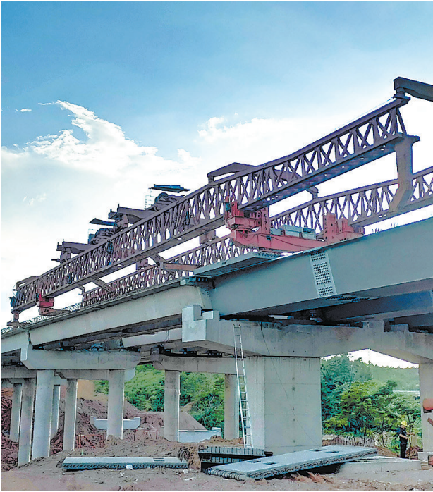
↑8月2日，中建五局江西分公司承建的G105改线项目香江大桥主线箱梁完成架设，提前一天完成既定目标，为实现“12·31”全线通车目标奠定坚实基础。该桥桥面长度574.5米，共18跨，需架梁120片。 郑孝雁 摄
