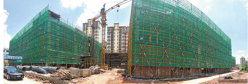
↑江西联网电子国际产业园项目一期工程主体基本完成。
