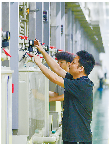
赣州逸豪新材料股份有限公司内,技术人员在对220万平方米面线路板、190万平方米多层线路板项目相关设备进行安装和调试。
