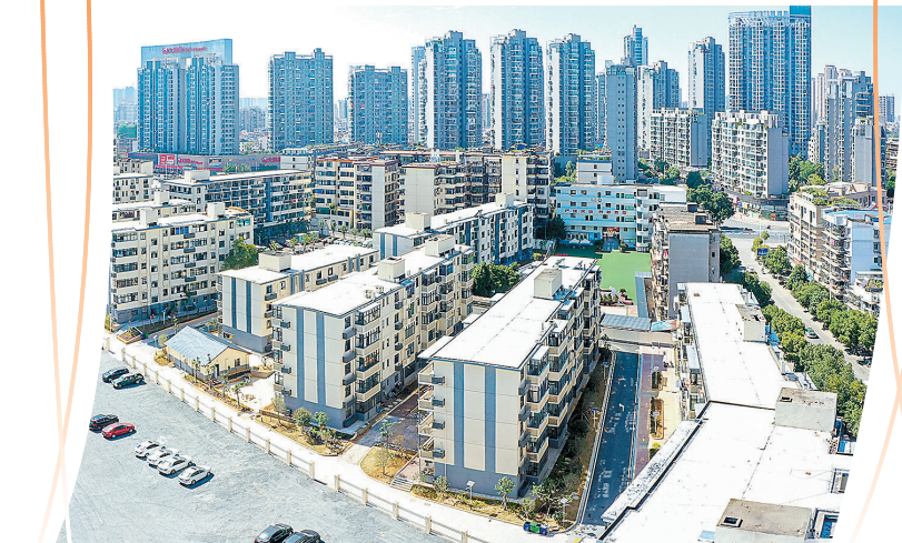
西桥路5号等一批老旧小区改造完成,居民幸福感得到新提升。
