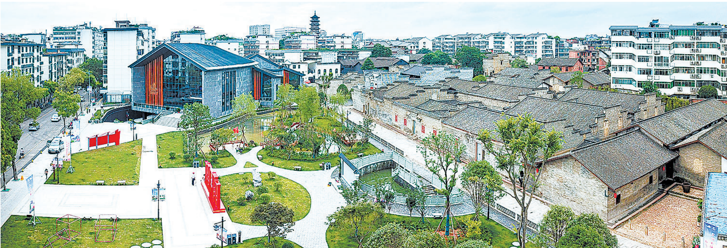
全国首个地下排水系统博物馆——福寿沟博物馆建成开放。
