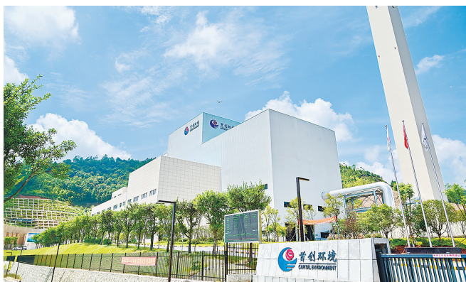
已建成的瑞金垃圾焚烧发电项目。
