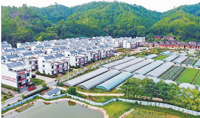
瑞金市叶坪镇黄沙村华屋小组一栋栋小洋楼鳞次栉比。整个村庄发生了翻天覆地的变化,村民的日子越来越美好,芝麻开花节节高。
