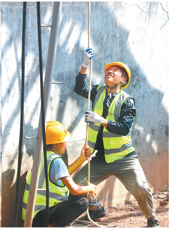
郭刚和肖贵明合力将5G基站设备拉上塔顶。
