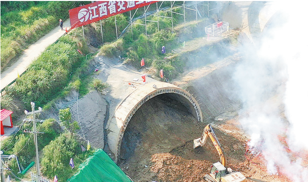
近日，遂川至大余高速全线最长隧道——五指峰隧道开挖。该隧道出口位于上犹县双溪乡水头村，进口位于吉安市遂川县左安镇固溪村，单幅全长4930米，是一座双向四车道分离式特长隧道，是全线重点控制性工程之一。记者吴悦 通讯员王健 摄
