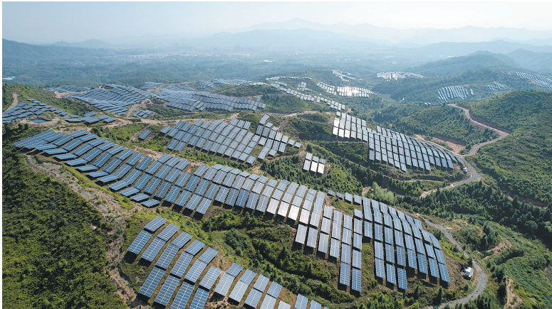
石城县琴江镇汉坑村协鑫光伏发电项目基地覆盖面积3000亩,总投资3.8亿元,装机容量60兆瓦,年发电量约6700万千瓦时。
