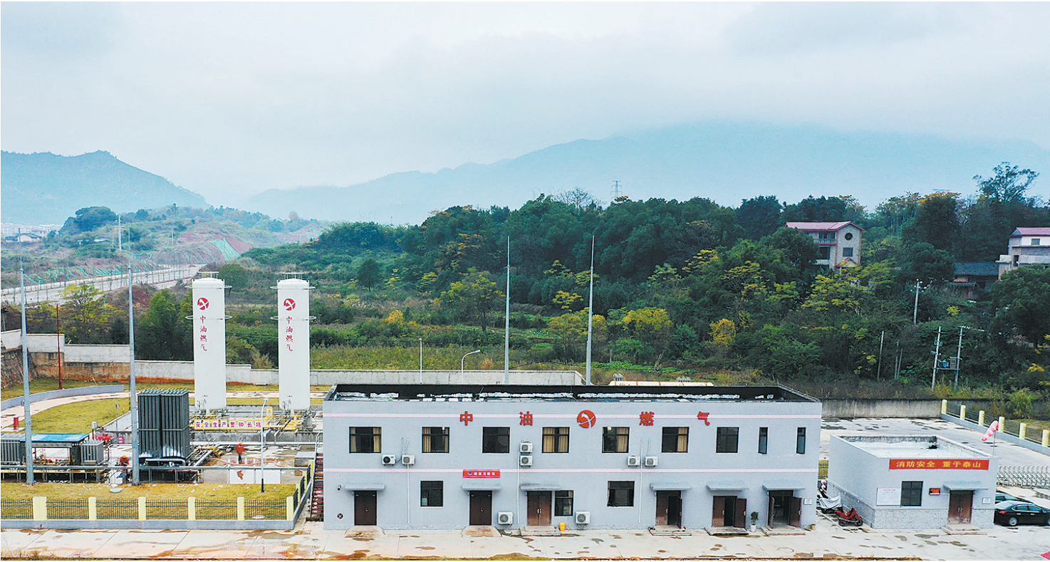
大余县天然气综合利用项目黄龙门站。
