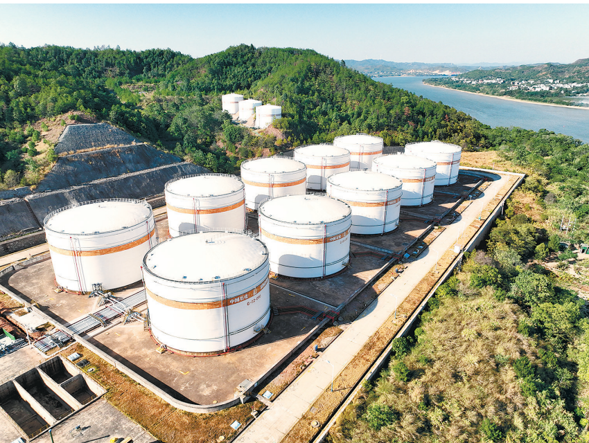
位于章贡区水西镇境内的中石化赣州石油分公司和乐油库作为樟树—吉安—赣州成品油管道的配套油库,保障了全市80%以上的成品油供应。
