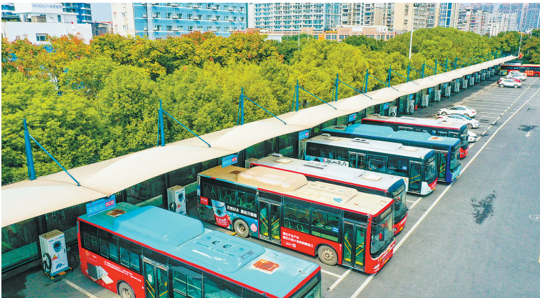
赣州火车站站前广场充电站,新能源汽车正在进行充电。
