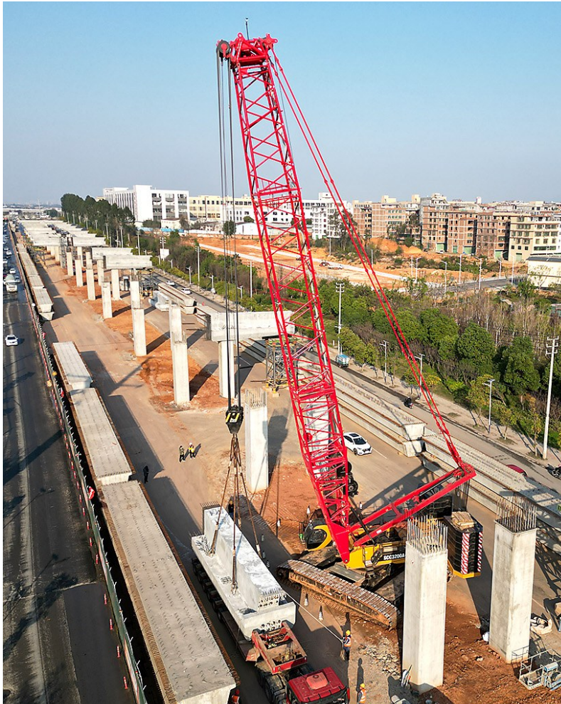
赣南大道快速路项目是江西省重点建设工程、赣州市重点民生工程。为抢抓雨季前工期，该项目今年春节期间不停工，近200名工人坚守岗位。图为1月22日工人在赣南大道快速路项目（南康段）吊卡装箱梁。 记者刘凯 摄
