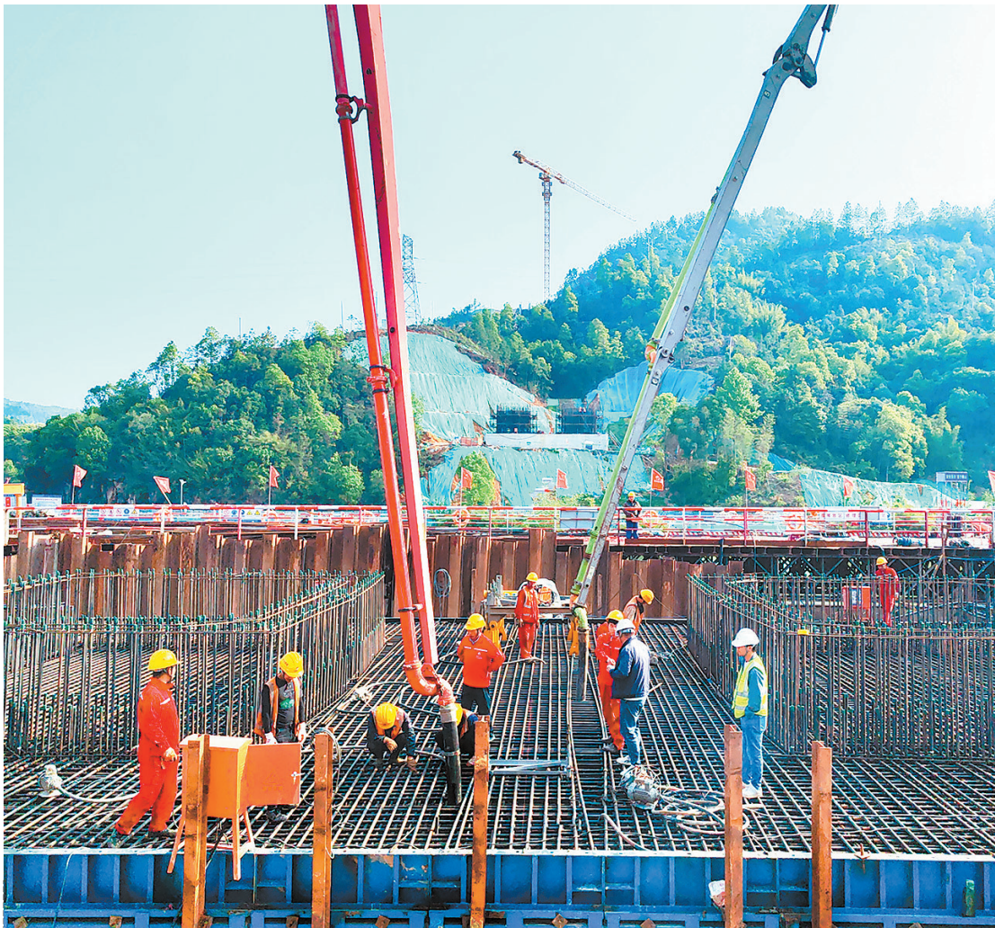
近日,位于上犹县陡水镇境内的遂大高速上犹江特大桥主墩承台浇筑完成,标志着上犹江特大桥进入出水施工阶段。据悉,江西交工遂大高速A标路基五分部承建的上犹江特大桥是遂大高速的关键控制性工程,桥长1419米,共7联24跨,最大跨径为160米。
