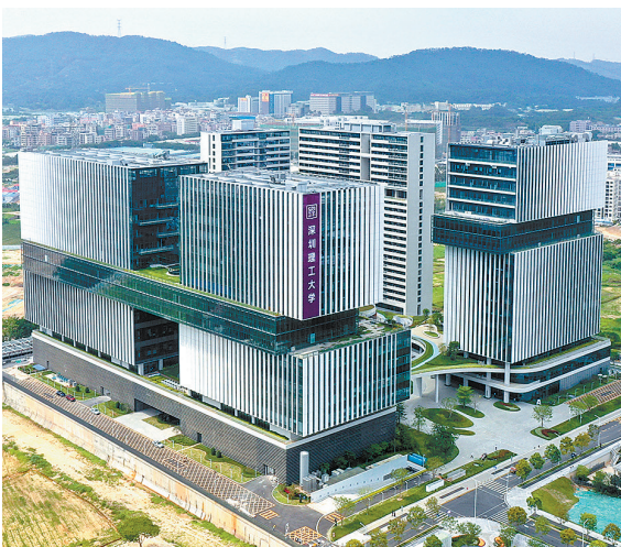
图为深圳光明科学城启动区外景。深圳光明科学城启动区是深圳建设综合性国家科学中心的核心承载区,总建筑面积约23.1万平方米,包含脑解析与脑模拟、合成生物研究两个大科学装置,以及综合研究院、专家公寓、青年公寓等。 新华社记者梁旭 摄
