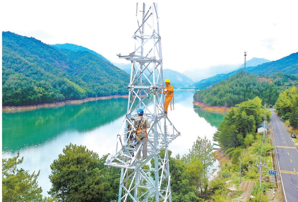
6月15日,上犹县五指峰乡10千伏晓水支线升级改造施工现场,工作人员在输电铁塔上开展联合作业。该工程有助于为当地224户村民输送优质电能,并安全迎峰度夏。 记者肖靓 通讯员罗理颂 摄
