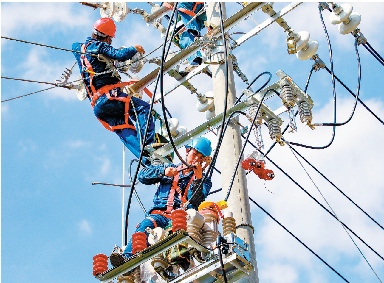
7月7日,电力工人在全南县南迳镇检修线路。连续的高温天气,社会用电负荷持续攀升。该县电力工人顶着高温,对重要供电线路、变电站进行巡视,及时开展检修及改造作业,确保电网安全运行和电力可靠供应。 李凡钦 摄
