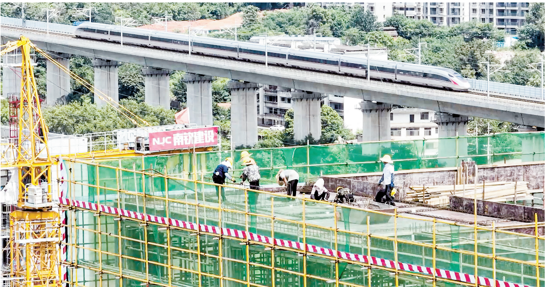
近日,赣州经开区一项目建设现场与飞驰的高铁相映成趣。据悉,赣州经开区始终保持“闯”的干劲推进项目建设,助力经济高质量发展。
