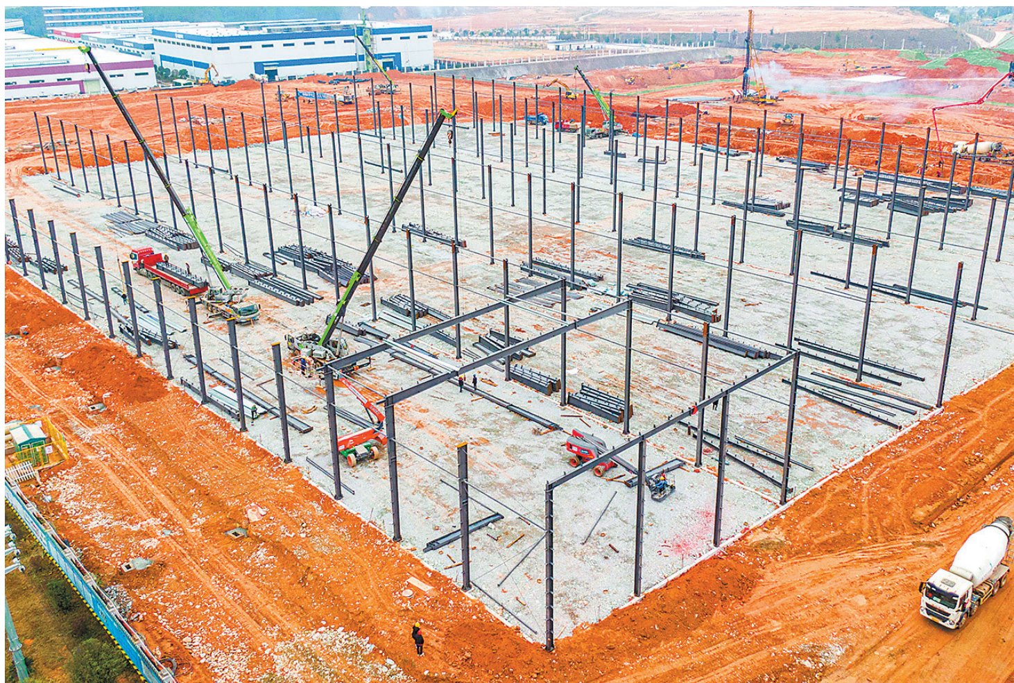
12月18日,位于定南县的赣粤际(定南)安全应急产业园标准厂房及配套基础设施建设项目一期施工现场,工人正在抢抓工期赶进度,确保各施工节点稳步推进。据悉,该项目占地面积共750亩,预计明年中完成建设,目前已完成项目建设总进度的30%,建成投产后将助推当地构建现代化、高水平安全应急产业体系,为创建国家安全应急产业示范基地打下坚实基础。 钟杰 摄
