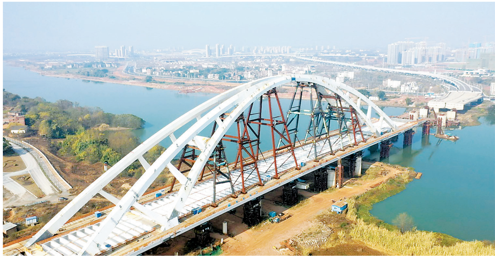
日前，在赣州蓉江新区创业大桥项目施工现场，大桥钢结构顶推作业正在进行，20台步履式顶推机同步运行，推动重达15000吨的桥体钢结构由南向北缓缓移动。创业大桥项目建成后将进一步完善蓉江新区交通路网，成为连接赣州西高铁站、赣州黄金机场的快捷过江通道，对推动新区高质量发展具有重要意义。
